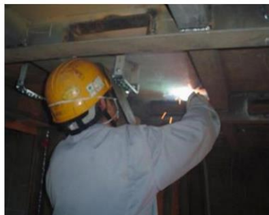
■工事の種類： 電路取付/主電路/溶接
