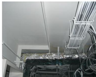
■工事の種類： 配線/配線/配線完了
