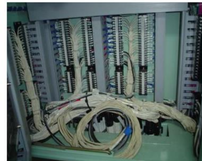
■工事の種類： 結線/結線/結線途中
