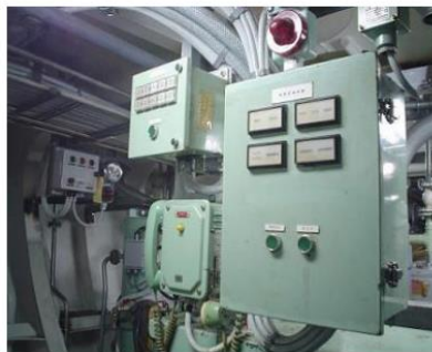
■工事の種類： 機器取付/機器取付/
