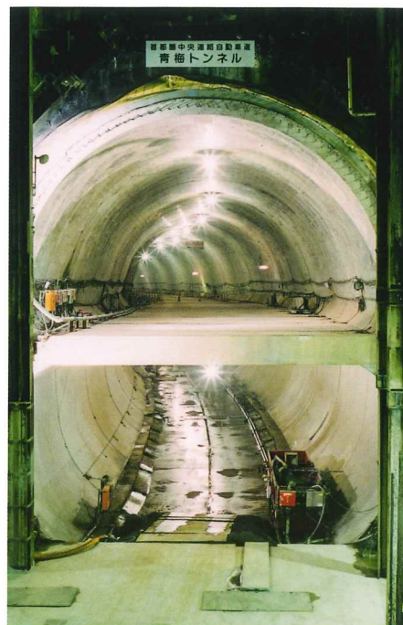
首都圏中央連絡自動車道 青梅トンネル北工区工事
