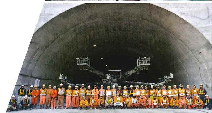
国道45号 気仙沼第2トンネル工事
