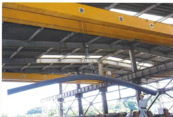
■天井クレーン
