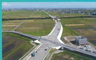
主要地方道鈴鹿環状線 磯山バイパス 道路改良工事
