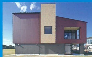
学校法人宣真学園 さくら幼稚園改築工事
