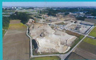
プリマ新御園工業団地造成工事
