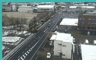
主要地方道神戸長沢線 鈴鹿IC前 道路改良（舗装）工事
