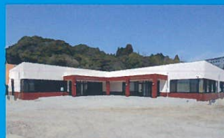
天名複合施設建築工事
