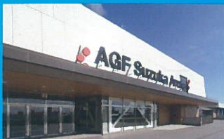
AGF鈴鹿体育館大規模改修工事
