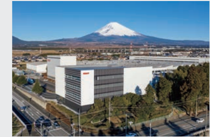
4 富士事業所 静岡県御殿場市大坂102-1 生産品目 移動・可動間仕切り/物流システム製品/商業施設用什器 ISO9001登録 ISO14001登録
