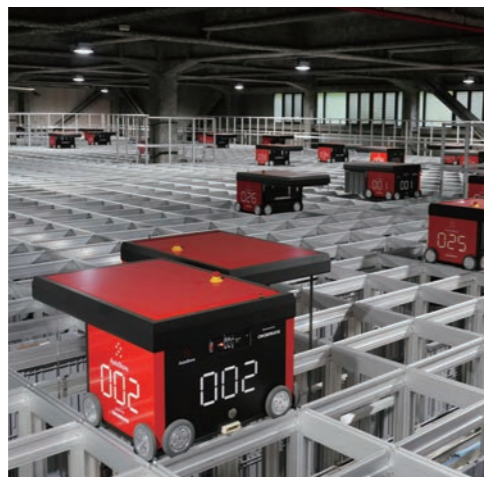
ロボットストレージシステム
