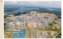
日本原燃六ヶ所再処理工場
