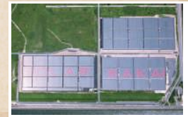
関西電力 堺太陽光発電所
