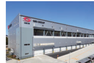
新杉田物流センター 2016年1月竣工 延床面積1万坪超 神奈川県横浜市磯子区杉田5-32-50 全館LED照明の採用、太陽光パネル設置で、低ランニングコスト・省エネを実現した環境にやさしい物流施設です。災害に備え、非常用発電機、インタンクを設置しました。
