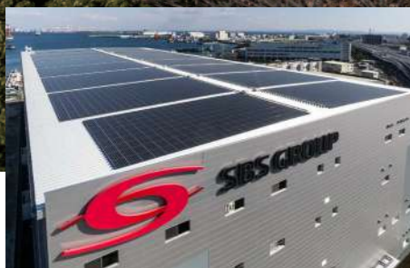
屋上に太陽光パネルを設置し、発電したグリーン電力の一部をセンター内で使用。環境に配慮した物流センター運営を行います。 ◀ 新杉田物流センター屋上
