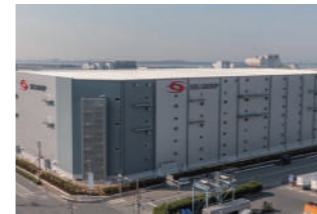
南港物流センター 2019年3月竣工 延床面積1万8千坪超 大阪府大阪市住之江区南港南2-5-8 阪神高速4号湾岸線沿い、大阪港、関西国際空港・大阪国際空港すべてにアクセスしやすい物流好立地。太陽光発電設備やLEDの導入に加え、24時間以上稼働できる非常用発電機を設置しています。
