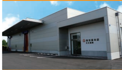
本巣屋井工場 2014年、日本で最新の設備を備えたはちみつ専用工場を稼働
