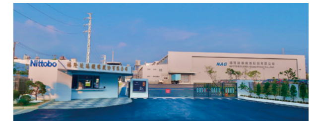
NITTOBO ASIA Glass Fiber Co.,Ltd.(台湾) にスペシャルガラス生産工場を新設
