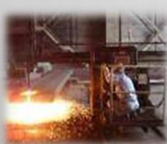
ガス切断作業
