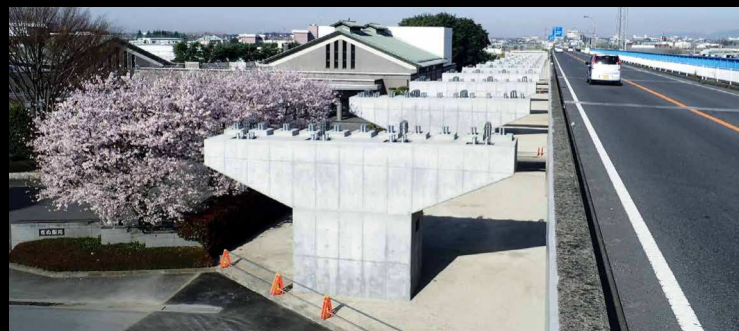
50号新川島橋下部(その1)工事
