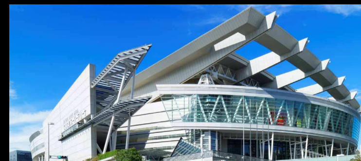
さいたまスーパーアリーナ新築工事(JV)
