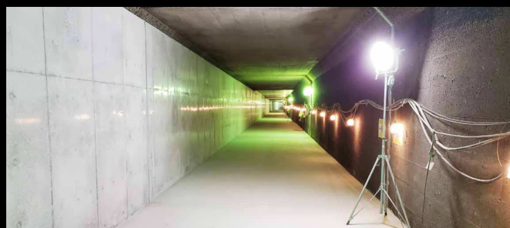
南部流域処理場放流渠耐震化4工事
