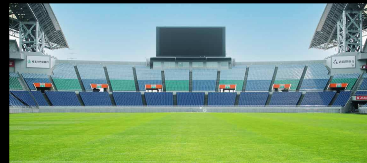
埼玉スタジアム2002観客席ほか改修工事(その3)
