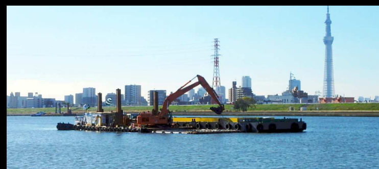
荒川下流堀切地区浚渫工事
