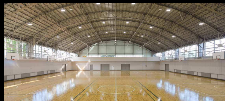
川口工業高校体育館ほか全体改修工事
