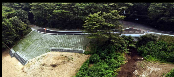
二本木線(4号箇所)森林管理道施設 災害復旧工事
