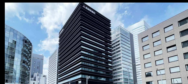
武蔵野銀行 本店 新築工事(JV)
