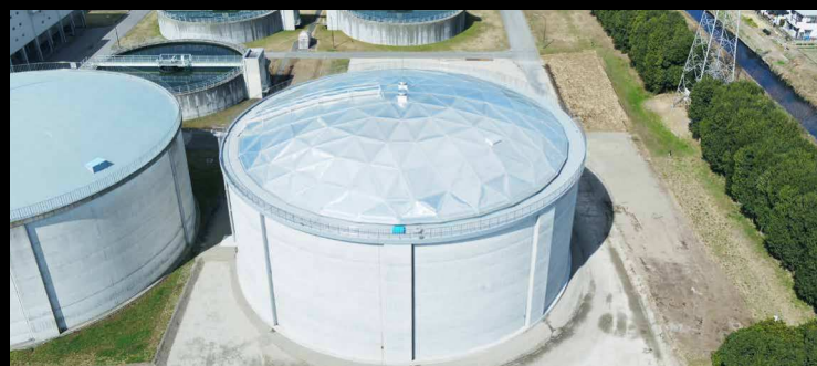
行田浄水場PC浄水池築造工事
