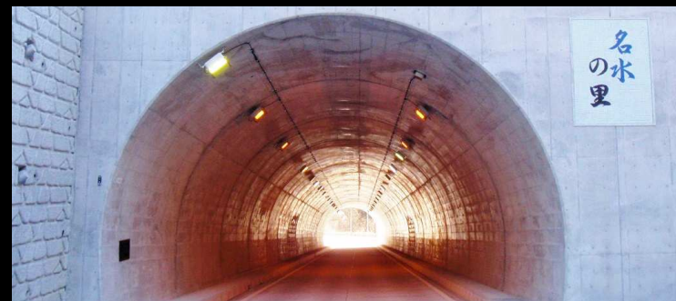
新要トンネル築造工事
