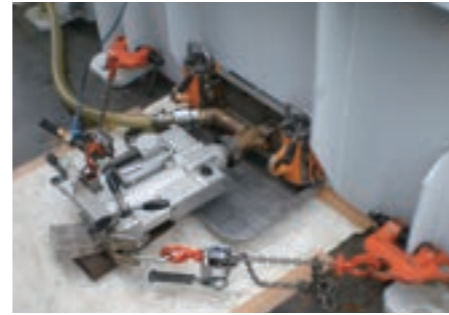
独自開発の技術が活かすトランス抜油工事
