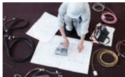
通信配線点検
