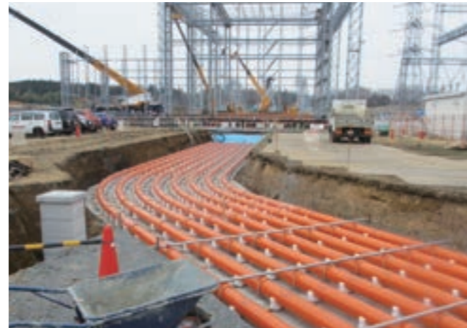
500kV変電所の電線管路埋設設置工事
