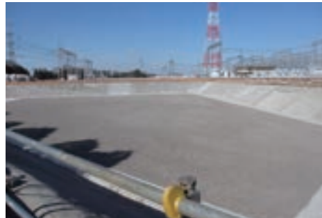
500kV変電所の調整池設置工事
