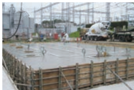
基礎工事からワンストップで効率よく作業
