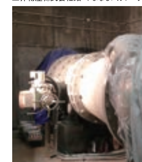
マイクロ水車発電機電気工事
