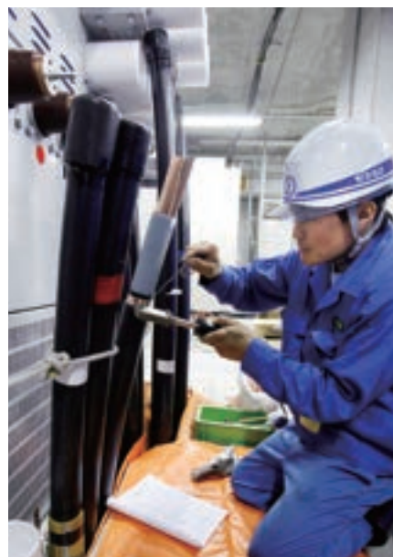
高圧ケーブルの端末作業
