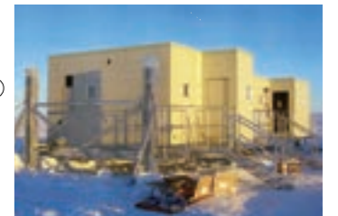
ジャッキアップ架台によるS17基地
