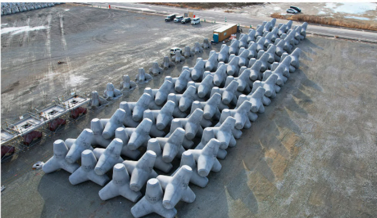
相馬港防波堤沖消波工事【福島県】
