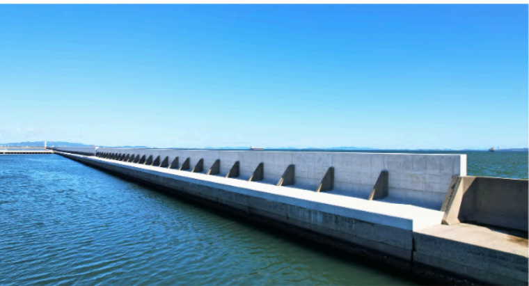
衣浦港防波堤改良上部工事【愛知県】
