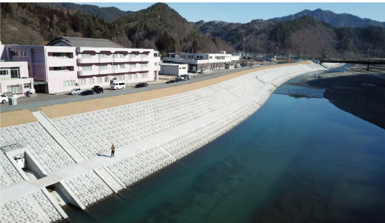
小本川災害対策特別緊急築堤工事【岩手県】
