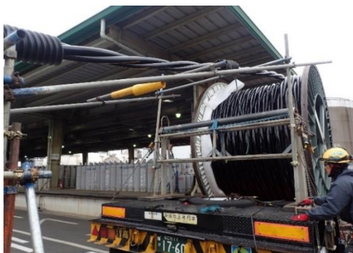
ケーブル布設
