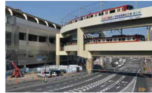
京急電鉄「京急蒲田駅」立体交差化工事
