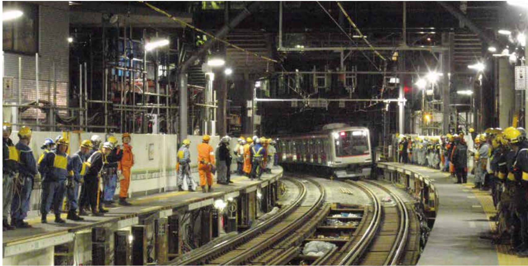
東急電鉄「代官山駅」地下化工事
