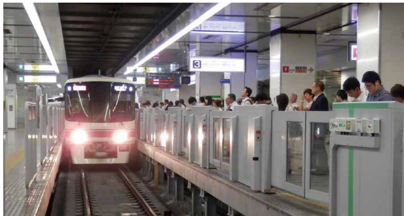
当社施工による京王線新宿駅ホームドア
