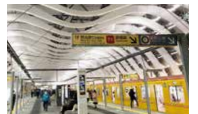
東京メトロ「渋谷駅」改良工事
