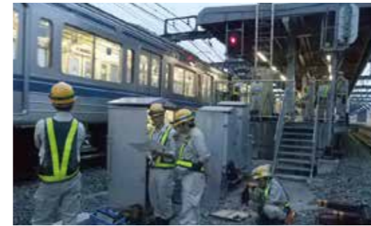
西武鉄道「石神井公園駅」複々線化工事
