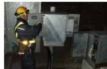
屋外にて D-ATS-P 切替作業
