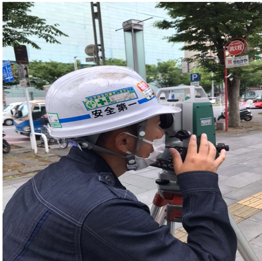
墨出し作業風景
