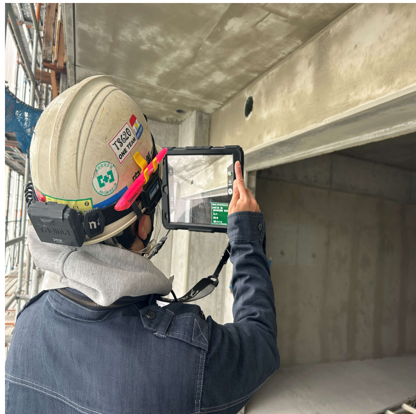
工事写真作業風景
