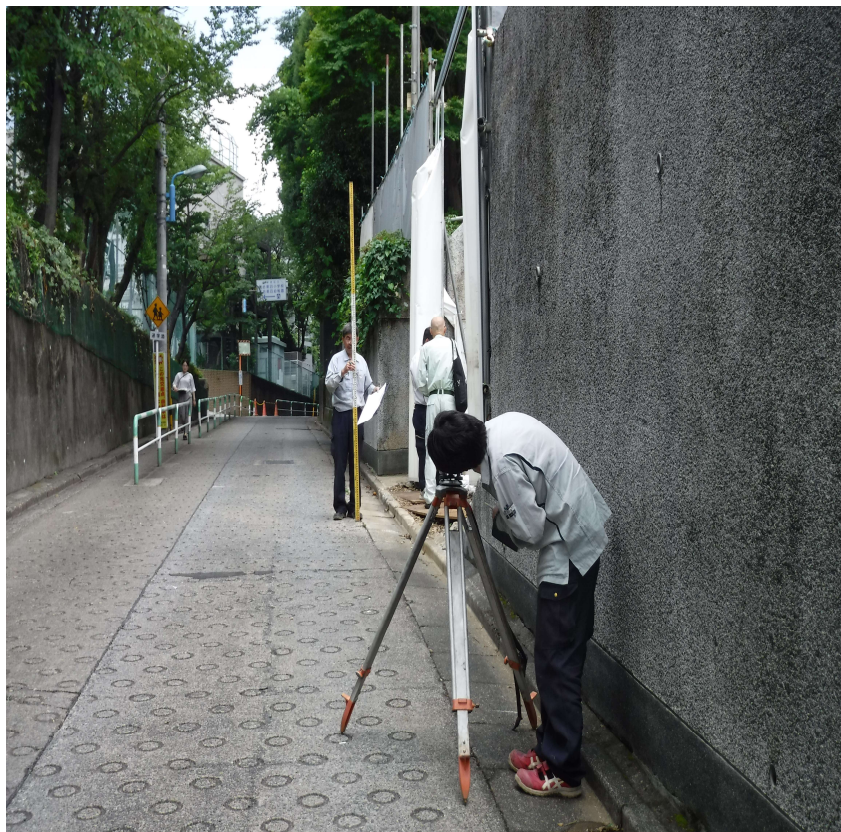
測量作業風景
