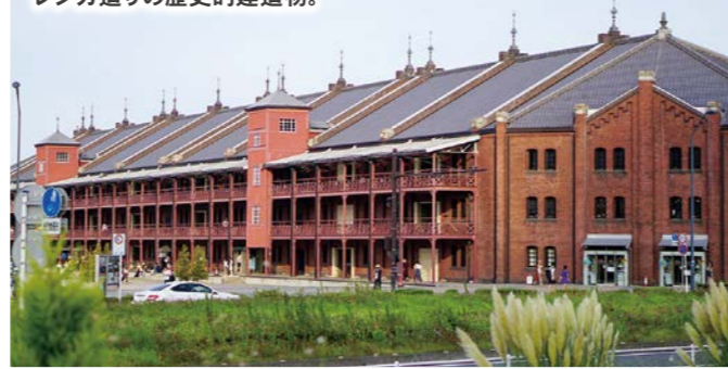
明治末期から大正初期に建設された レンガ造りの歴史的建造物。
