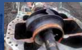
■ 両持ちポンプの分解整備作業
