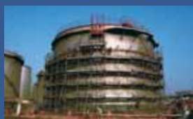
■ 3,000kℓタンクの浮き屋根式から固定屋根への型式変更工事
