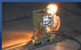
■ タンク底板 サブマージーク溶接
