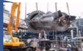
■ 高圧ポンプの取り外し作業
