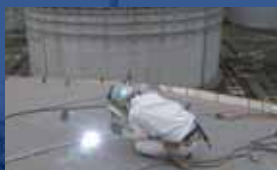
■ 40,000kℓタンクの屋根板取替えによる溶接作業
