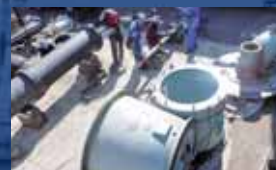
■ 竖型ポンプの分解後、整備作業
