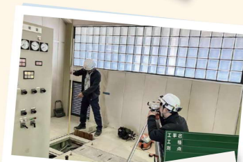
制御盤据付作業
