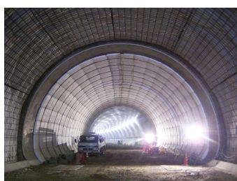
EPSパネル養生工法
