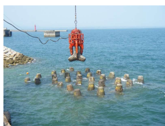
グラブ式異形ブロック 撤去装置
