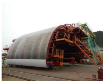
トンネル覆工コンクリートへの透水性型枠の適用方法
