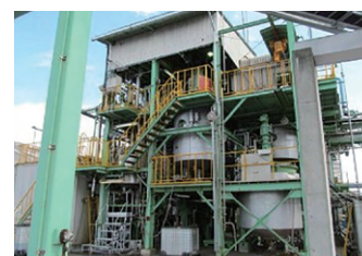
工場外観(八戸工場)
