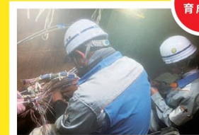
地下ケーブル接続指導
