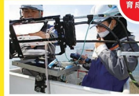
光ケーブル接続作業
