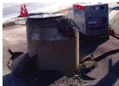
ガリガリ君工法 フロートレス工法
