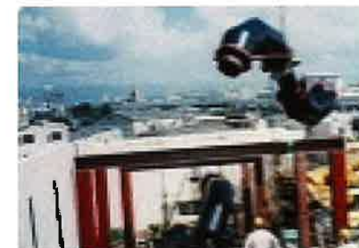
管路再生工事—開削工事
