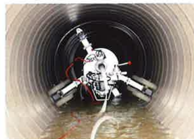
EPR工法・EX・クリアフロー工法 ダンビー工法・パルテムSZ工法
