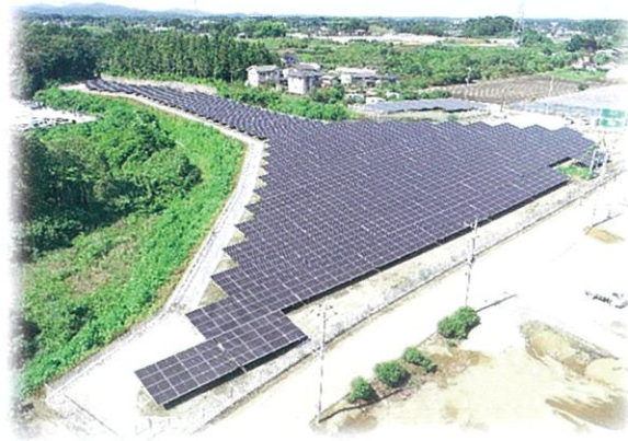
太陽光パネル設置工事
