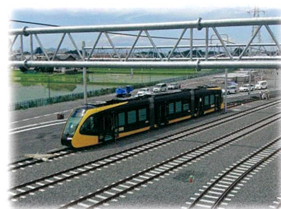
宇都宮LRT軌道新設工事
