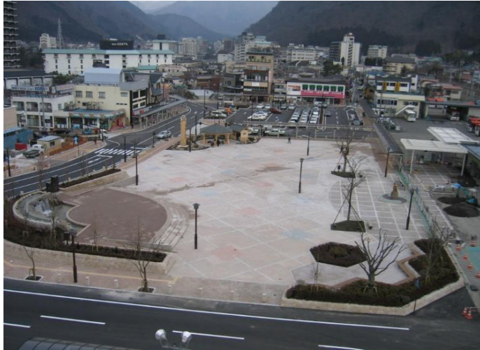
■鬼怒川温泉駅外構工事【栃木県日光市】
