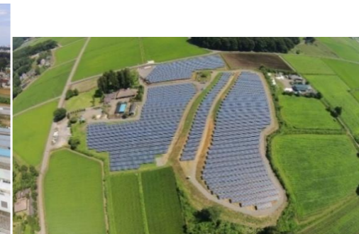
■ 日光市内太陽光発電所2,418KW
