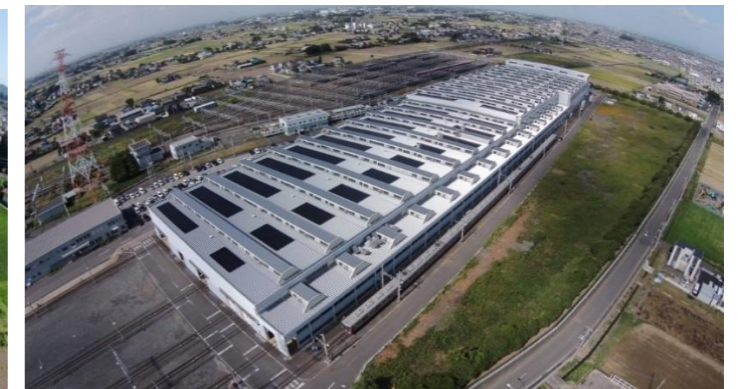
■ 東武南栗橋発電所778KW
