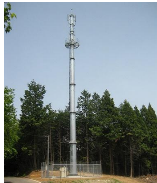
■ 基地局(屋外局) 地上に高さ20m~40mの鉄塔を建設し、その上部にアンテナを設置する「鉄塔局」とマンションやオフィスビル等の屋上にアンテナを設置する「建物局」の2種類があります。鉄塔局は、近隣に高い建物がない地域や、郊外に建てられ広い範囲のエリアをカバーし、建物局は様々な設置条件や環境に合わせることで通信エリアの拡大に努めています。大規模建物等不特定多数の人々が従来する建物内部(インクス)及び地下鉄駅構内等に無線基地局を設置しております。屋内でも快適な通信環境を実現するため、通信サービス提供会社と協力して、整備を進めています。
