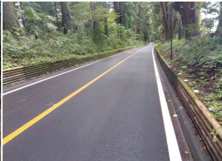
■舗装修繕工事121号その1(道保全単)【栃木県日光市】
