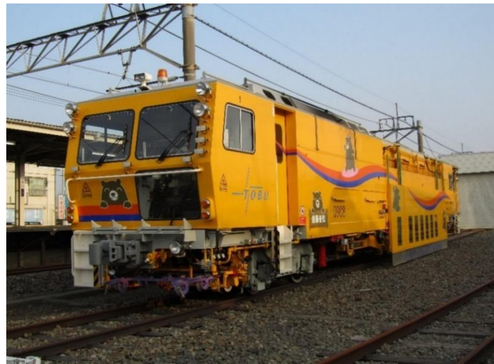
■ 09型マルチ 一般軌道、道床搦固めによる通り・高低水準などの整正を行う
