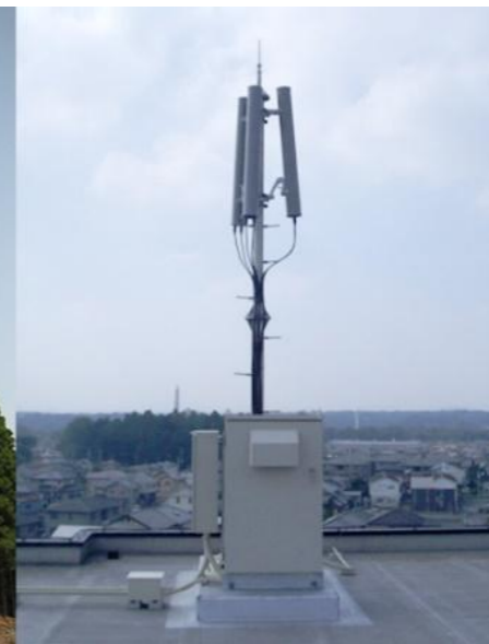
■ 基地局(屋外局) 地上に高さ20m~40mの鉄塔を建設し、その上部にアンテナを設置する「鉄塔局」とマンションやオフィスビル等の屋上にアンテナを設置する「建物局」の2種類があります。鉄塔局は、近隣に高い建物がない地域や、郊外に建てられ広い範囲のエリアをカバーし、建物局は様々な設置条件や環境に合わせることで通信エリアの拡大に努めています。大規模建物等不特定多数の人々が従来する建物内部(インクス)及び地下鉄駅構内等に無線基地局を設置しております。屋内でも快適な通信環境を実現するため、通信サービス提供会社と協力して、整備を進めています。
