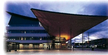
日光市役所新築工事
