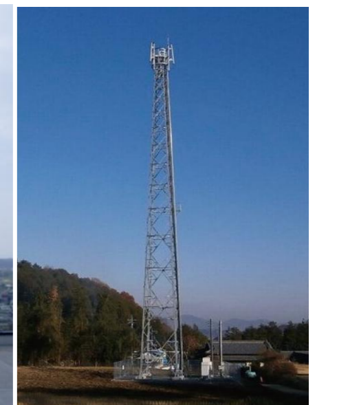
■ 基地局(屋外局) 地上に高さ20m~40mの鉄塔を建設し、その上部にアンテナを設置する「鉄塔局」とマンションやオフィスビル等の屋上にアンテナを設置する「建物局」の2種類があります。鉄塔局は、近隣に高い建物がない地域や、郊外に建てられ広い範囲のエリアをカバーし、建物局は様々な設置条件や環境に合わせることで通信エリアの拡大に努めています。大規模建物等不特定多数の人々が従来する建物内部(インクス)及び地下鉄駅構内等に無線基地局を設置しております。屋内でも快適な通信環境を実現するため、通信サービス提供会社と協力して、整備を進めています。
