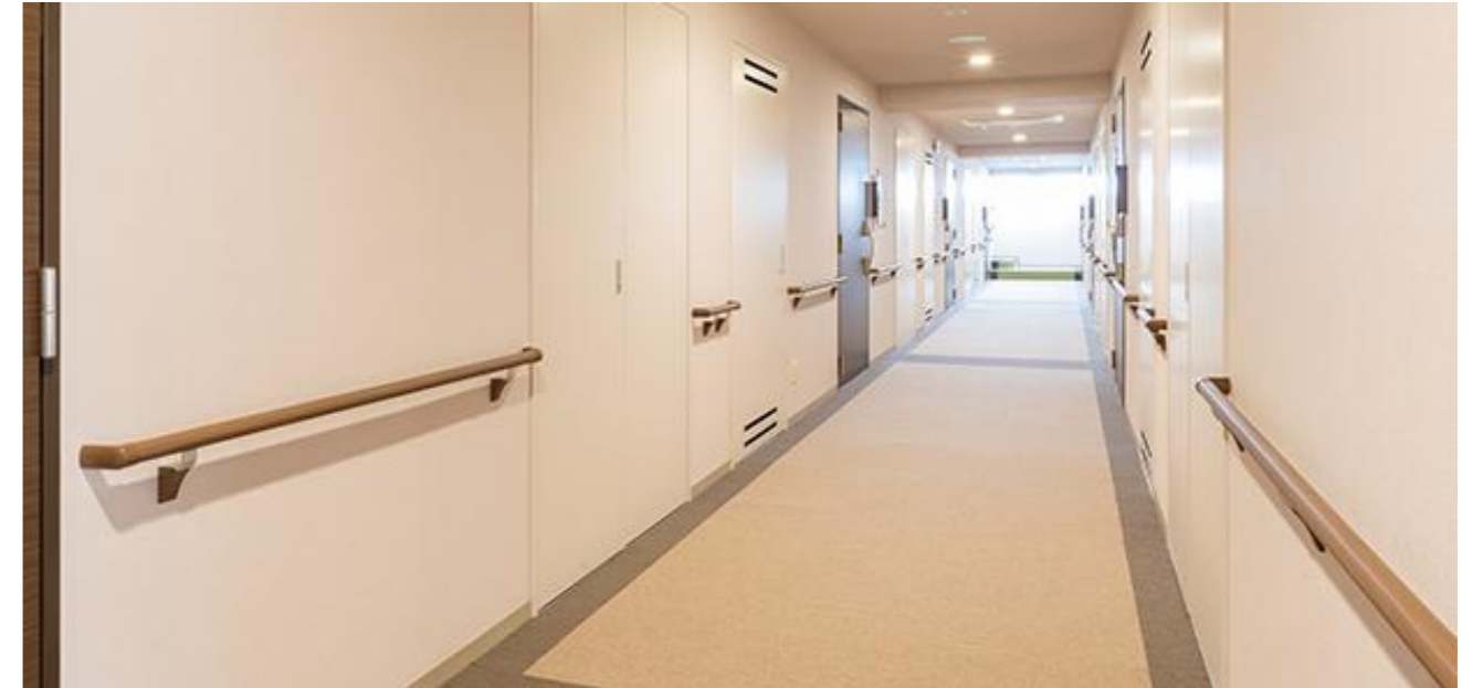
歩行用手すり
