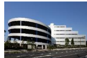
⑧東京 ロジスティクスセンター
