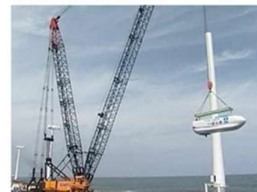
風車の羽を付けるハブを取付
