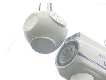
風車の羽を付けるハブを取付
