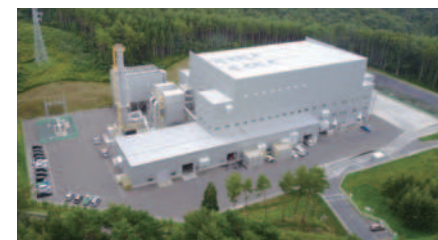
バイオマス発電所
