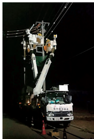
2019年9月10日千葉県台風15号時の復旧作業
