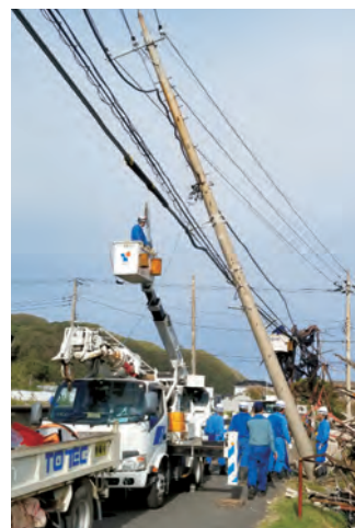
2019年10月14日千葉県台風19号時の復旧作業
