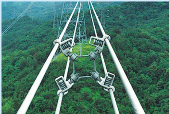
▲ 径間スペーサ (ボルトレススペーサ) クランプ内のスプリングにより送電線を常に一定の力で把持する多導体スペーサ Main span spacer (of boltless type) Gripping conductors with a constant force of the spring contained in the clamp
