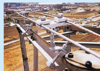
▲ OPGWクリート(配線金具) Cleat for OPGW (for making connections)
