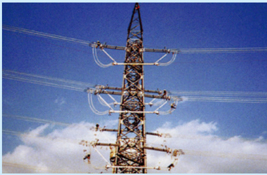
▲アルミパイプ式ジャンパ装置 アルミパイプ導体を使用したジャンパ装置 Jumper device of aluminium pipe type Jumper device using aluminium pipe conductor
