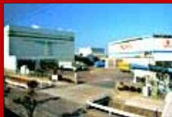
愛知工場 (愛知県安城市)
