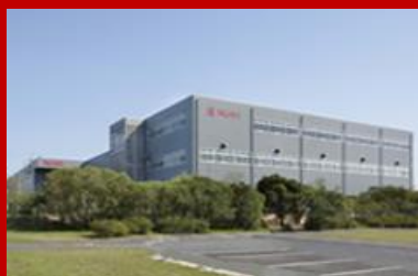
鈴鹿工場 (三重県鈴鹿市)
