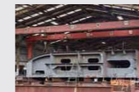
アッセン(大組立)組立作業
