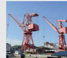
70トン・80トン塔型クレーン
