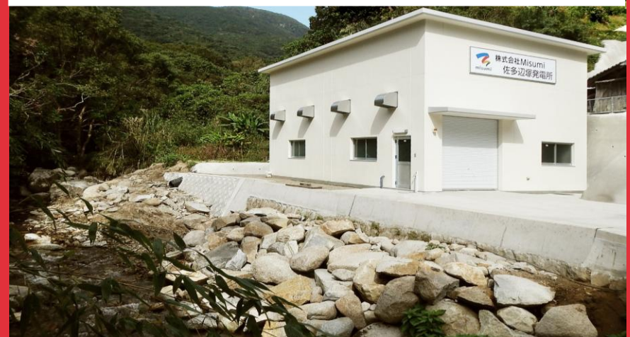
【小水力発電所】
