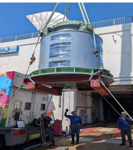
重量物の吊上げ・設置作業
