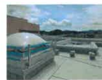
各種金物の設置
