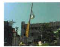
重量物搬入据付
