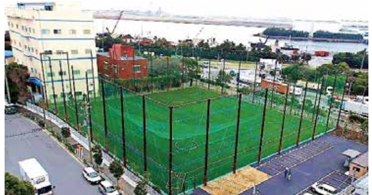
城南島ポータルランド整地工事(大田区)
