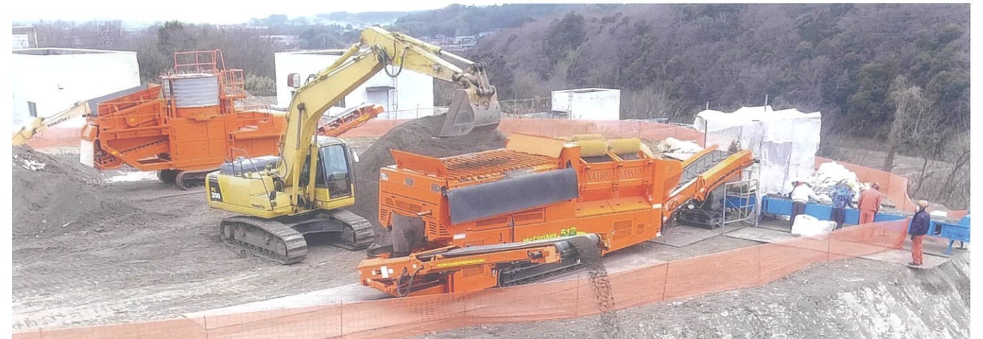
当社が所有する土質改良機、大型ふるい機に加え、風力選別をすることで土に混じったごみを取り除くことに成功しました。(2019年:台風19号)
