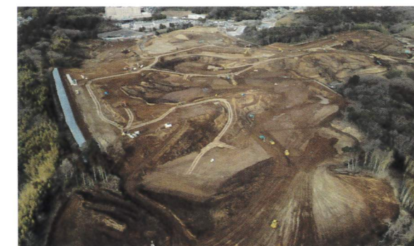
市原市海保地区開発造成工事(千葉県)
