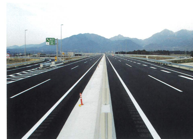
新名神高速道路 孤野舗装工事(孤野IC付近)
