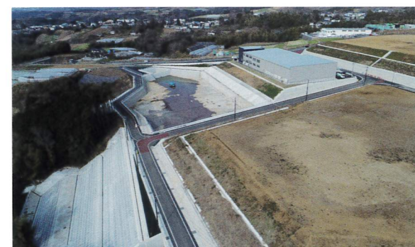
三島三ツ谷工業団地敷地造成工事(静岡県)
