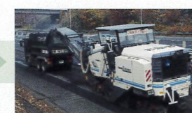
切削機等で舗装を撤去
