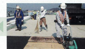
舗装工事に使用
