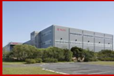
鈴鹿工場 (三重県鈴鹿市)
