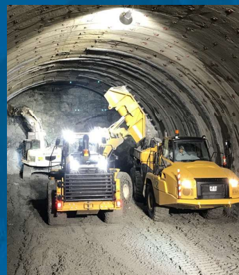
土砂をダンプに積み込み、坑外へ搬出する
