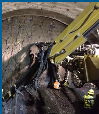
大量の爆薬を設置し、爆破することで岩盤を砕く
