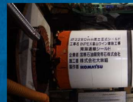
掘削前のマシン上部
