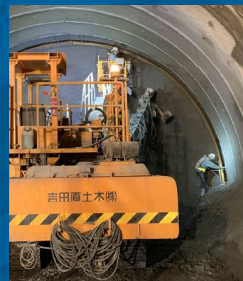
アーチ形にトンネルを支える支保工を建て込む
