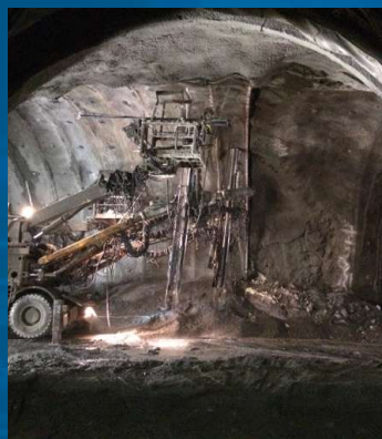
大型重機ドリルジャンボによる掘削作業
