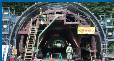
セントルによるトンネル坑口打設
