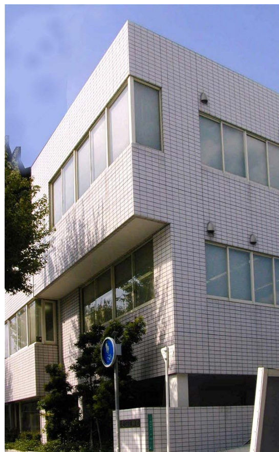
本社ビル（平成10年10月増築 自社施工）
