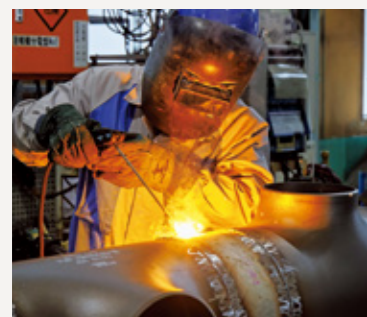
作業の進捗率を把握し、納期厳守で作業を行っています。
