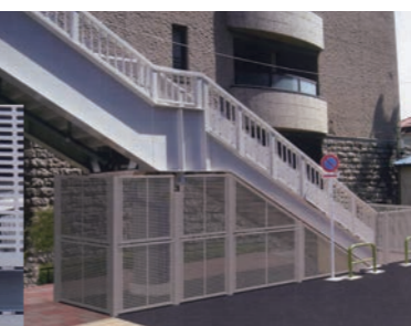
▲パンチング 施工例 ◀ビル外壁 アルミ10X44 長孔パンチング
