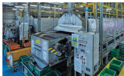
省エネ効果を高める断熱ジャケット (熱処理設備)
