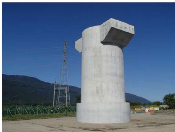
【岐阜県】東海環状津屋川橋P10橋脚工事
