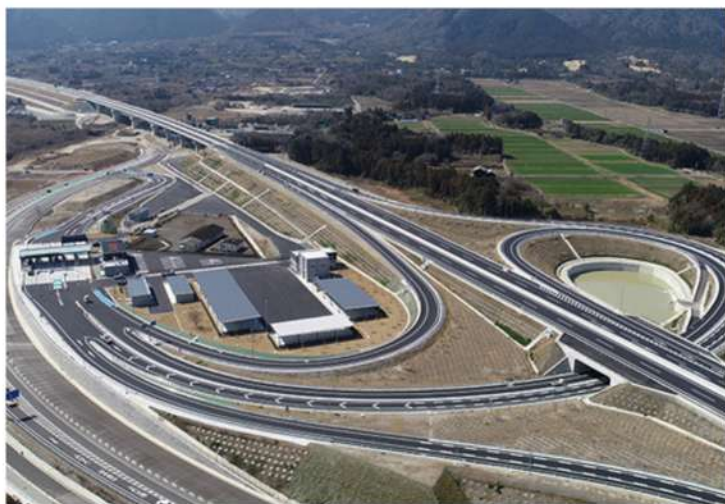
【三重県】四日市ジャンクション建設工事
