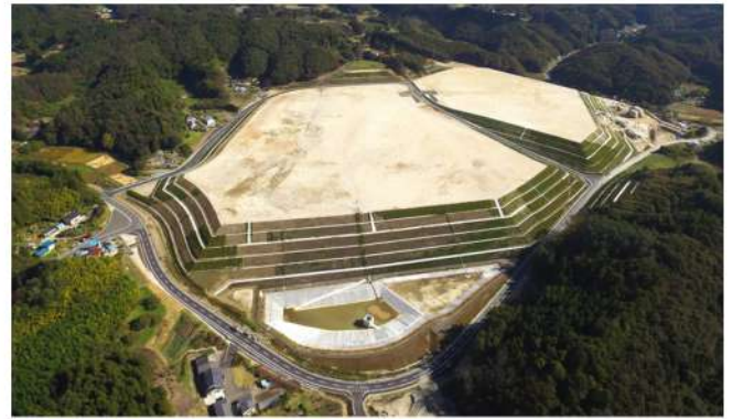
【福島県】田村市東部産業団地造成工事
