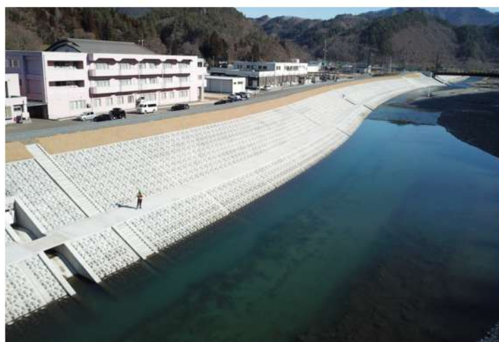
【岩手県】小本川災害対策特別緊急築堤工事
