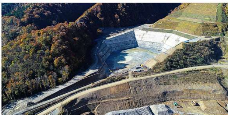
【秋田県】成瀬ダム原石山採取工事
