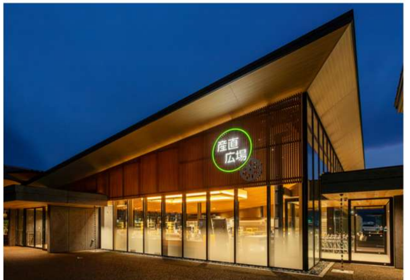
【愛知県】愛西市 道の駅再整備工事
