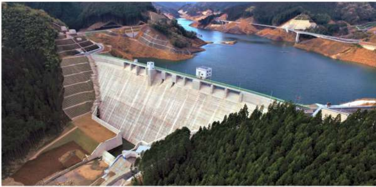
【福岡県】伊良原ダム建設工事
