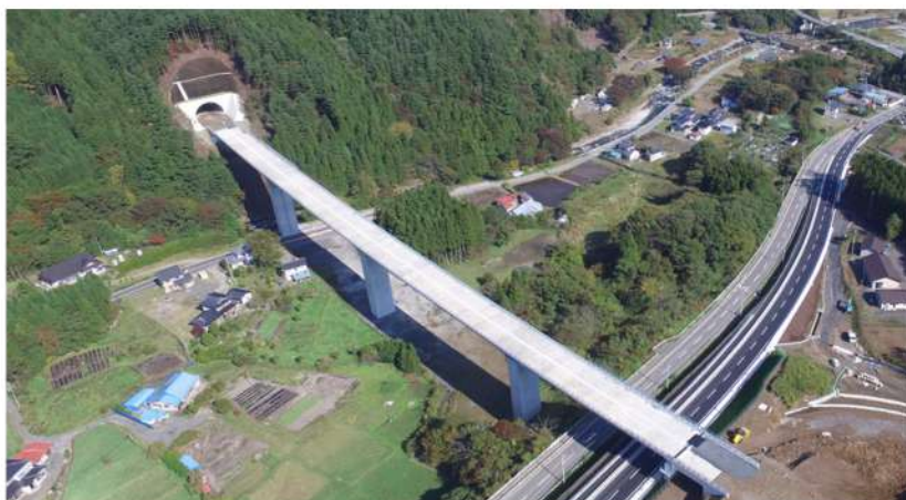
【岩手県】新釜台トンネル工事
