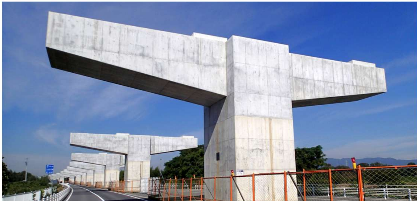
【三重県】東海環状自動車道東一色橋梁下部工事
