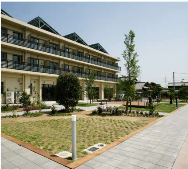
サービス付き高齢者向け住宅施設新築工事
