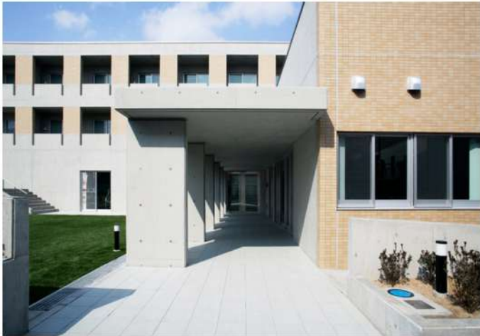
民間企業社員寮新築工事
