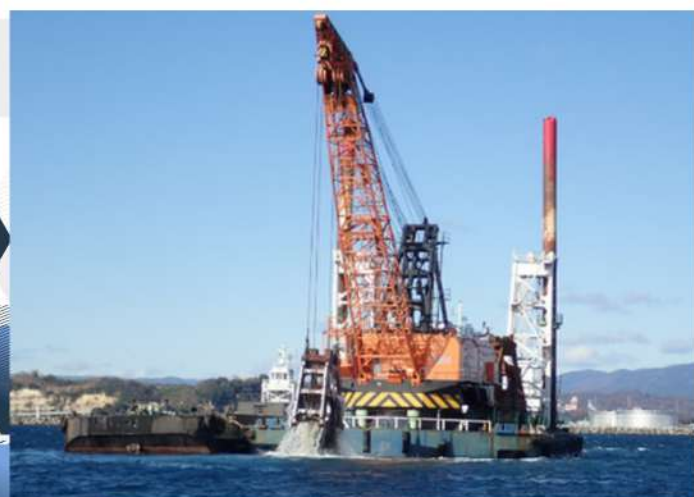
【福島県】小名浜港東港地区航路浚渫工事
