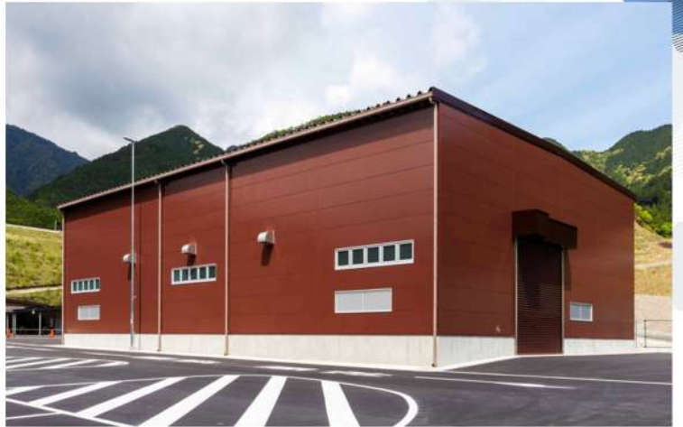
【三重県】42号尾鷲南パーキング防災施設新築工事
