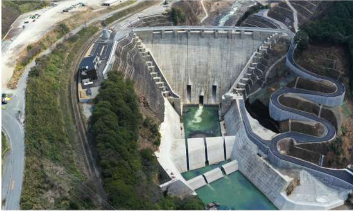
【熊本県】立野ダム建設工事
