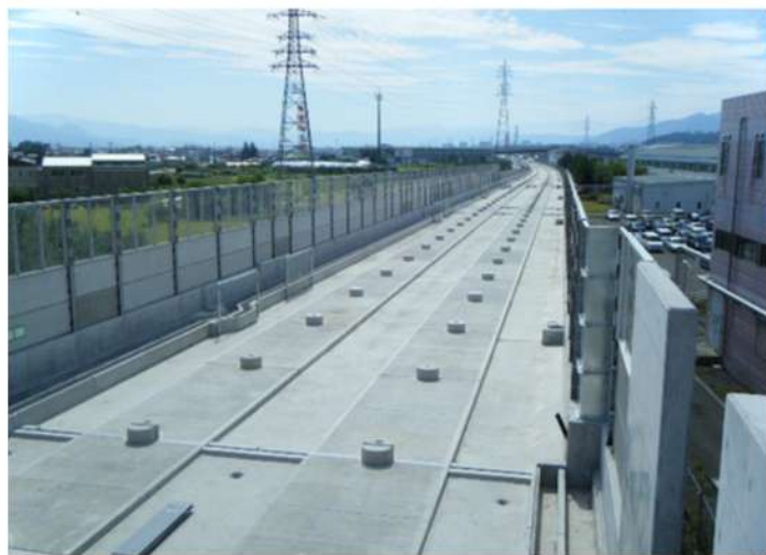
【長野県】長野赤沼高架橋工事
