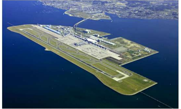
【愛知県】中部国際空港建設工事
