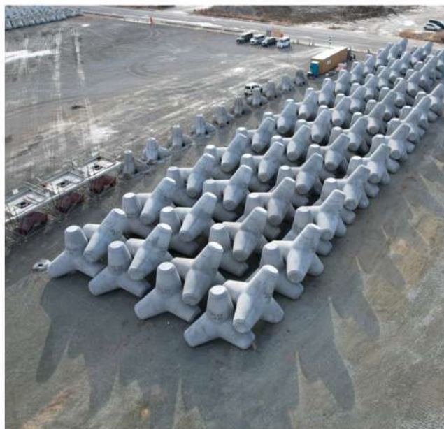
【福島県】相馬港本港地区防波堤沖消波工事
