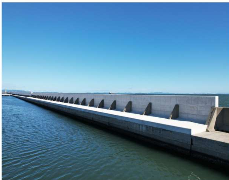
【愛知県】衣浦港防波堤改良上部工事
