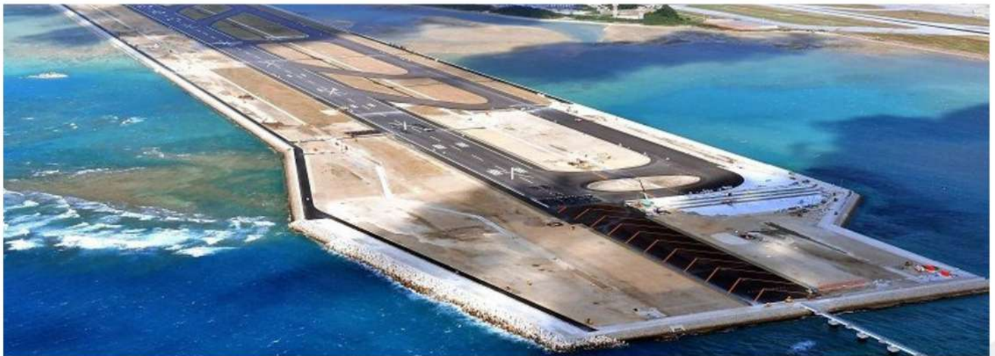
【沖縄県】那覇空港第二滑走路建設工事
