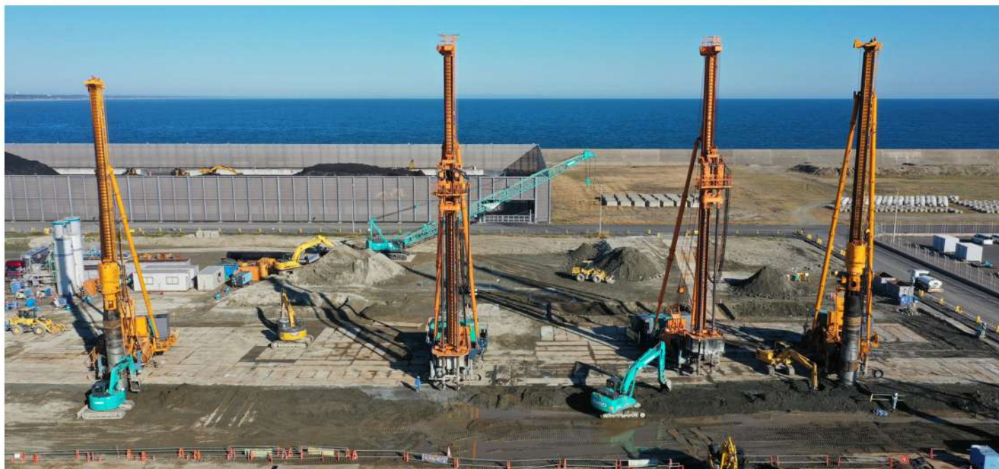
【茨城県】鹿島港外港地区岸壁地盤改良工事
