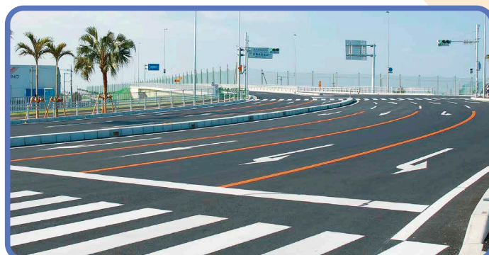
▲豊見城道路(沖縄県豊見城市)
