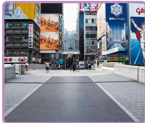
▲戎橋(大阪府大阪市)【インジェクト工法】
