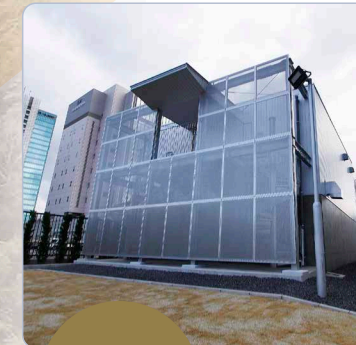
中日美容専門学校防災倉庫 (愛知県名古屋市中区)
