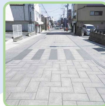
▲一番町大工町線(福島県白河市) 【インジェクト工法】
