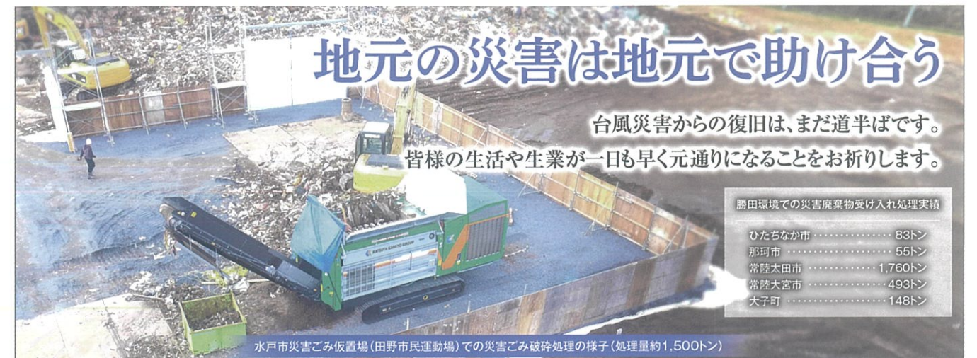
市町村の災害廃棄物仮置場に移動式の大型破砕機を設置し、現場破砕を行うことで処理の迅速化を図りました(2019年:台風19号) ※写真は茨城新聞社に掲載された広告です
