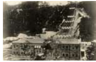
支笏湖畔・ナツソウの滝に建設した水力発電所
