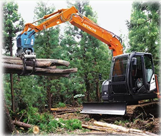
林道開発の樹木伐採工事
