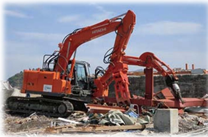
宮城県南三陸町の復興現場
