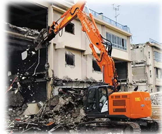
解体作業の工事現場
