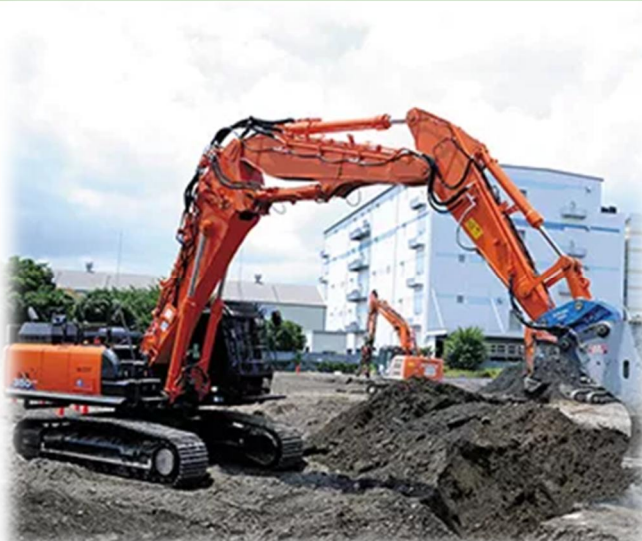
建築現場の土木工事
