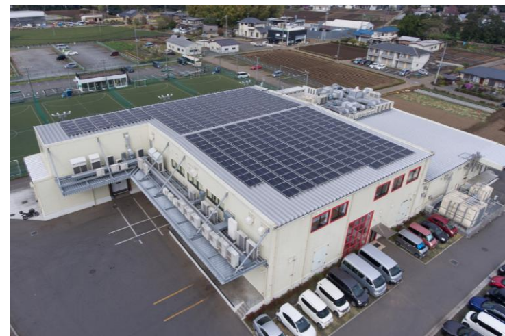
セントラルキッチン 狭山工場 (2019年竣工)
